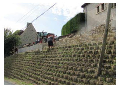
Habillage pierres en cours
