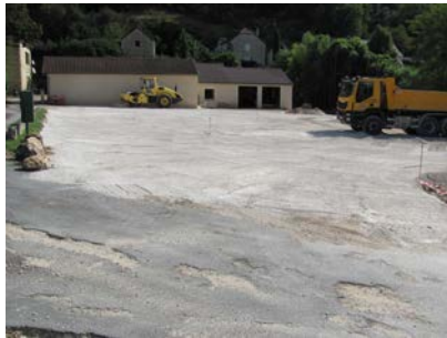
Début travaux plateforme
