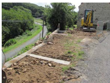
Structure béton armé terminée
