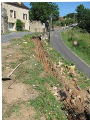
Fondation et ferrailage
