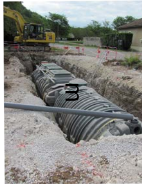
Nouvel assainissement commun
