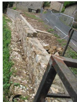
Habillage pierres en cours
